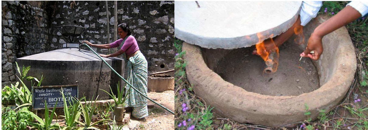
Revisando la válvula de gas de un reactor biogás de cúpula flotante en India (izquierda) y encendiendo la llama del biogás (derecha, Lesoto, 2006). Fuente: BIOTECH India (2007) y MUENCH (2008).
